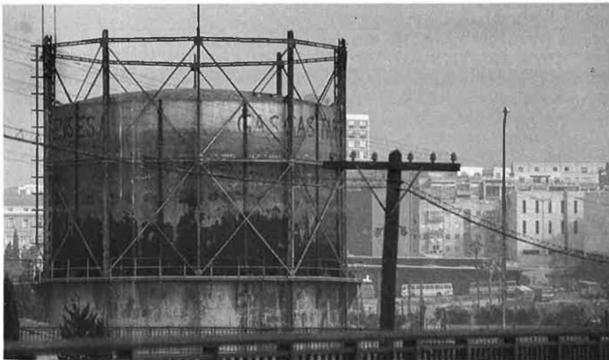
Depòsits de material inflamable, molt pròxims a les vivendes.
