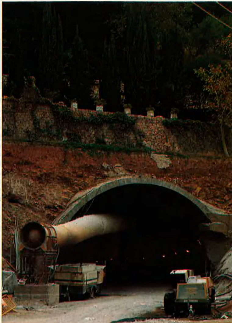
Les boques del túnel, tancades. La muntanya no es deixa foradar.
