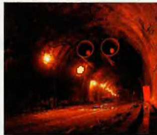
S'inaugura el túnel del Cadí, peça bàsica de l'anomenat eix del Llobregat (29-10).
