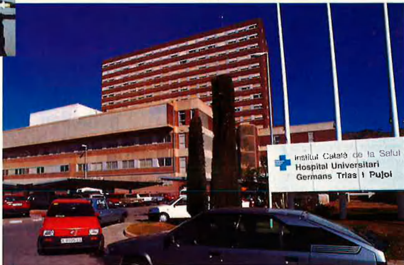
L'hospital Germans Trias i Pujol, a Badalona, ha tingut transformadors contaminats sense saber-ho. A l'esquerra, vista d'un transformador com els afectats.
