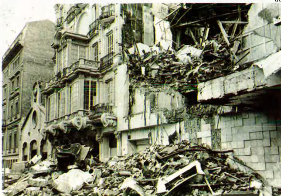
La sala de festes Scala, després de l'incendi del 15 de gener de 1978. L'afer Scala va suposar el començament de la fi de la CNT.
