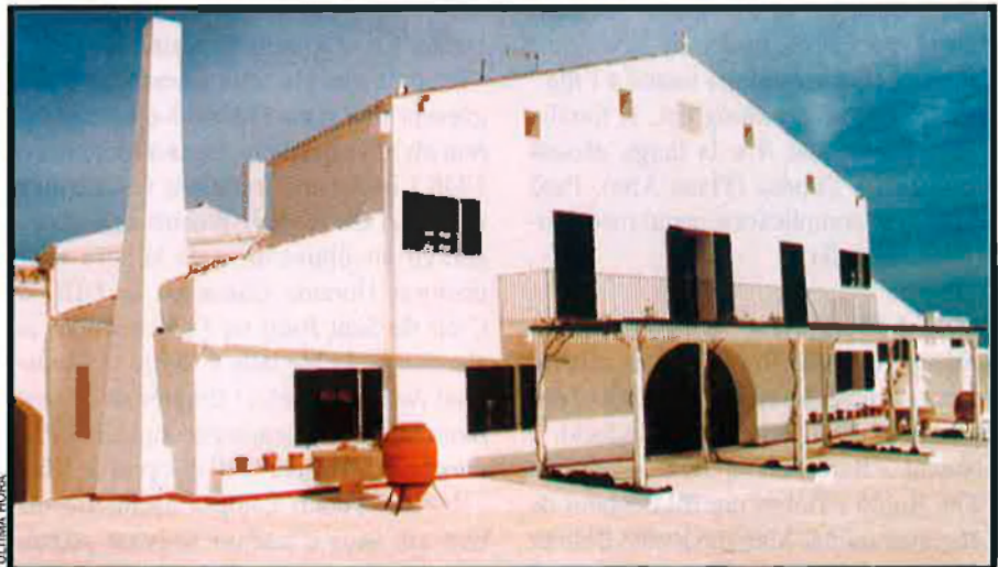
Finca de Mongofre Nou, que compta amb una casa d'arquitectura clàssica menorquina, 400 hectàrees i accés únic a una platja. Els Aznar no podran gaudir d'aquest indret paradisiac.
