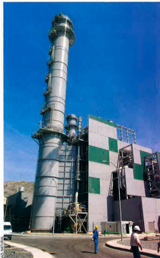
Planta de cycle combinat Plana del Vent (Tarragona) de Gas Natural.
