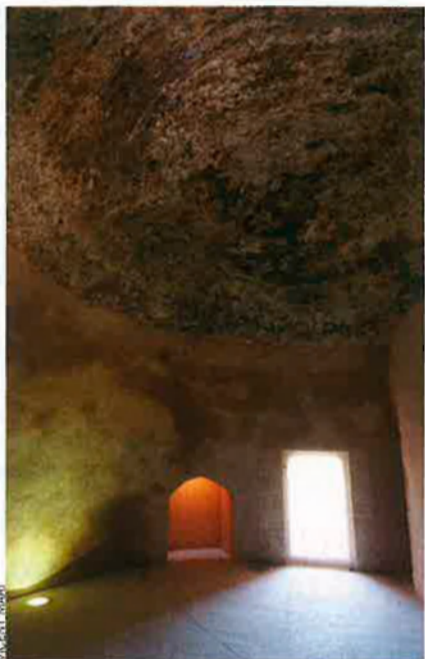
Interior de la torre des Carregador, ara restaurada.
