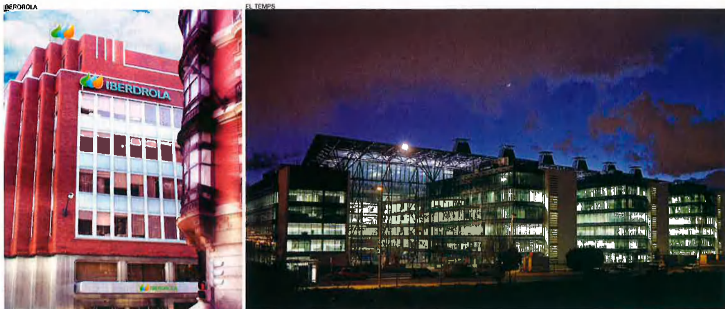
A l'esquerra, la seu central de la companyia elèctrica Iberdrola, a Bilbao; al costat, la seu d'Endesa, situada a Madrid.
