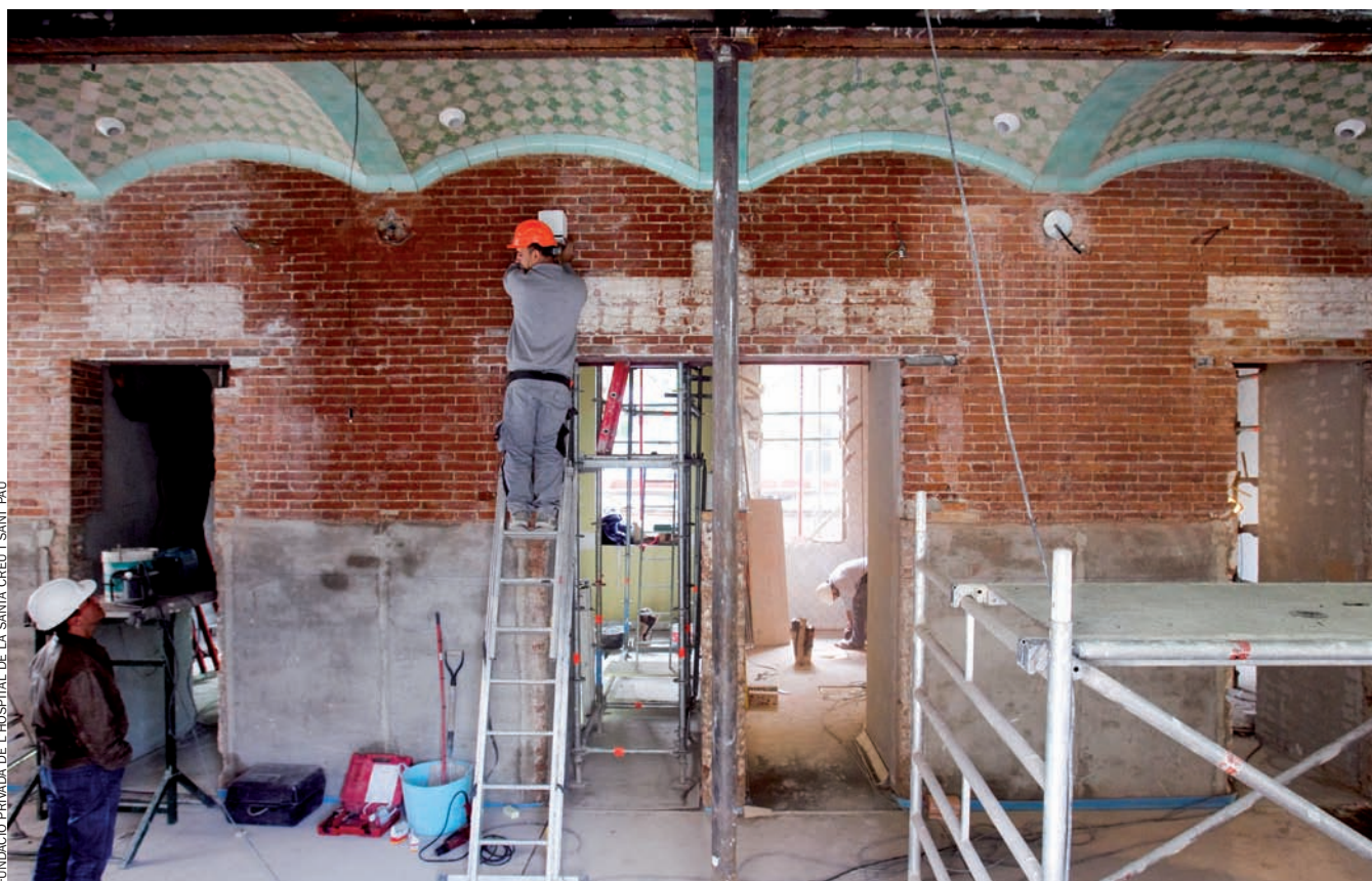
Uns obrers de la construcció treballen en la rehabilitació d'un dels pavellons de l'Hospital de la Santa Creu i Sant Pau.
